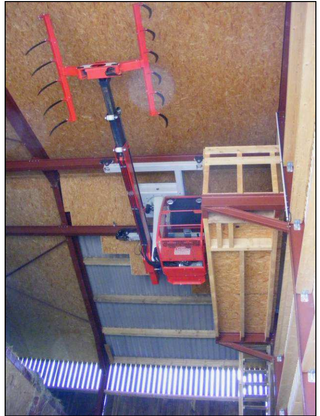
Griffe pour rentrer et sortir le foin des cellules En haut : faux-plafond permettant de récupérer la chaleur du toit et utilisé par les ventilateurs En bas : bardage ouvert pour extraire l'air chargé d'eau lors du passage à travers le foin
